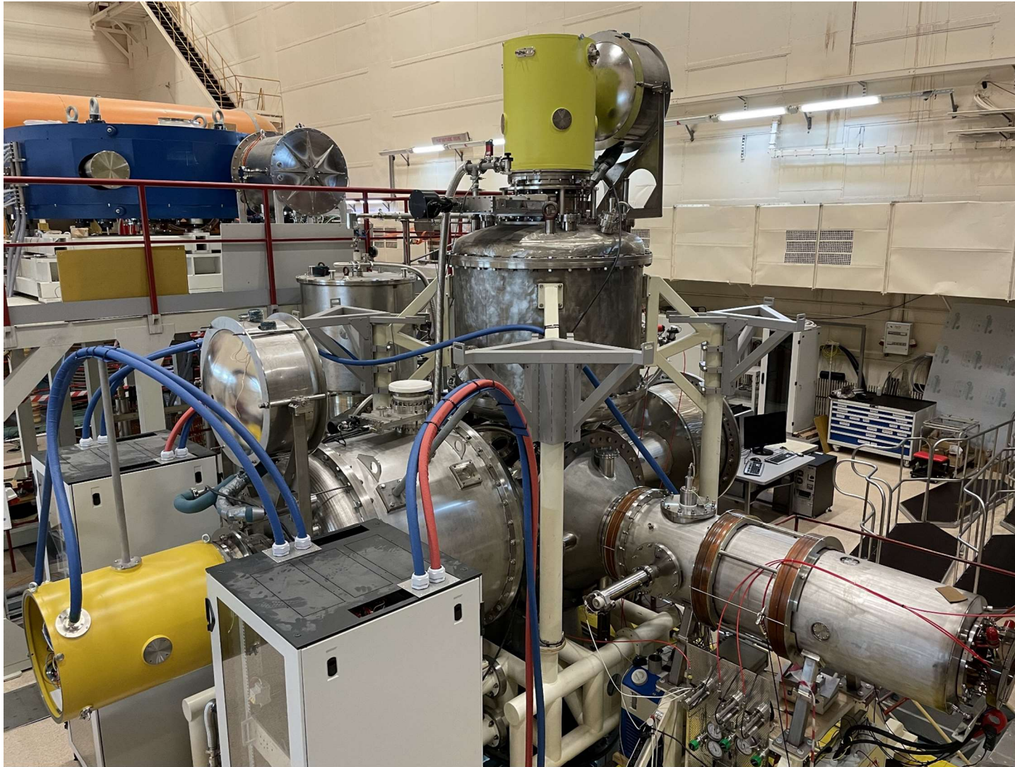
Установка КОТ. Защищённый зал здание 20.
